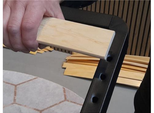
Legen Sie nun alle quadratischen Bodenplatten auf den Boden. Wenn alle Platten unten sind, beginnen Sie mit dem Lattenrost. Nehmen Sie 1 Latte und stecken Sie sie in das Loch der Befestigungskappe am Mittelsteg des Rahmens.
